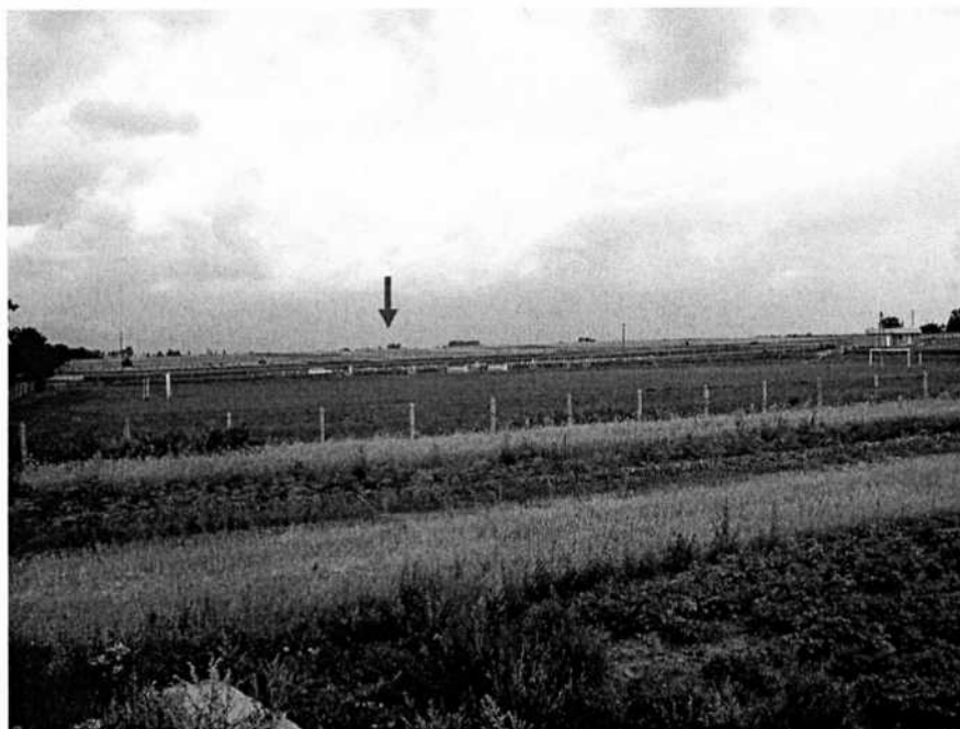
Zdjęcie wykonane od strony nalogu (w innym dniu niż miało miejsce zdarzenie). Czerwoną strzałką zaznaczono miejsce uderzenia w linię energetyczną.
