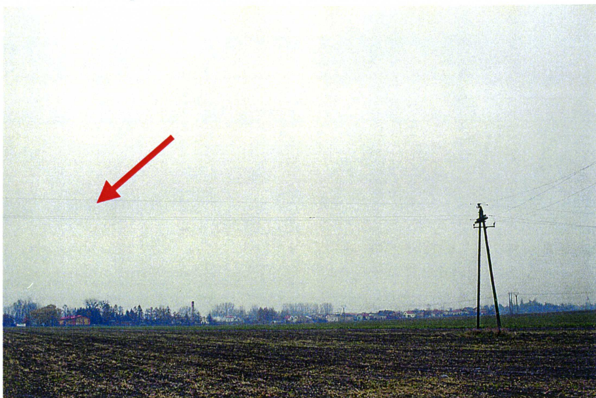
2. Widok naprawionych przewodów linii energetycznej biegnących od słupa od strony południowej.
