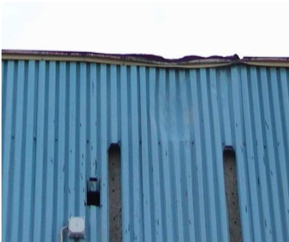
Fot.1 – Ślad uderzenia samolotu na ścianie budynku i krawędzi dachu.
