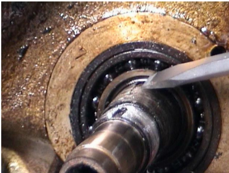
Fot.12 – Wałek 13M-05-03 ułożyskowany w obudowie skrzyni reduktora 13M-01-03; ostrze śrubokręta wskazuje na widoczne w rowku wałka resztki ściętego wpustu 13S-00-87.
