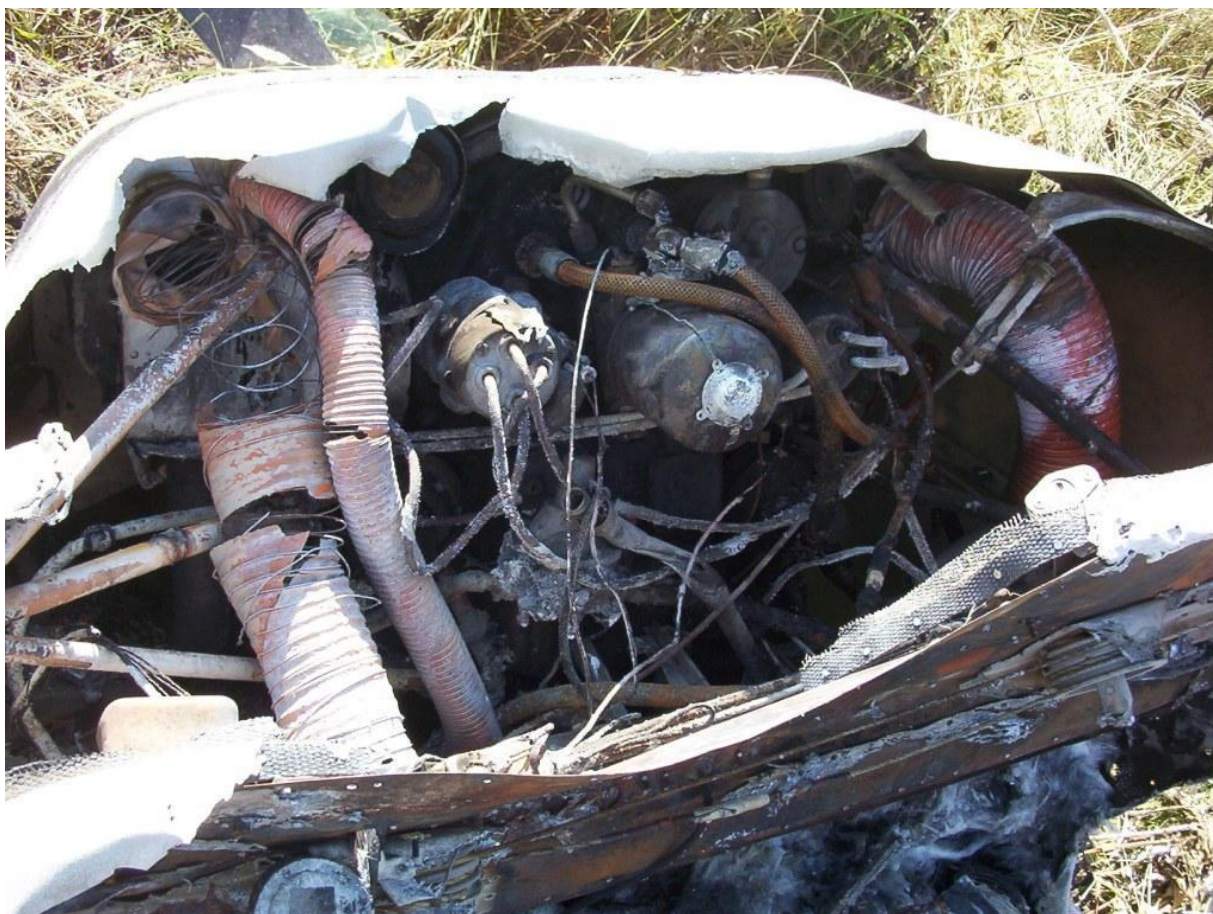
15 – Zniszczone pożarem agregaty i instalacje zespołu napędowego, widok od tyłu. Na pierwszym planie przegroda ogniowa.
