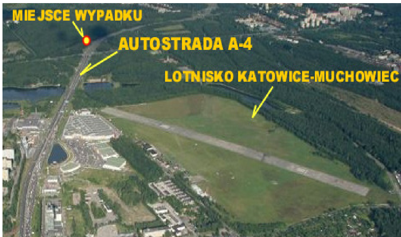
Fot.1 – Widok rejonu wypadku z lotu ptaka.
