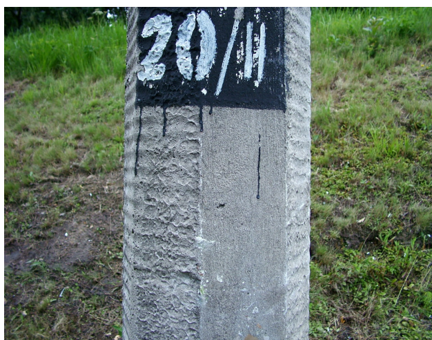
Fot.7 – Słup latarni przy zjeździe ze śladem uderzenia końcówką prawego skrzydła.
