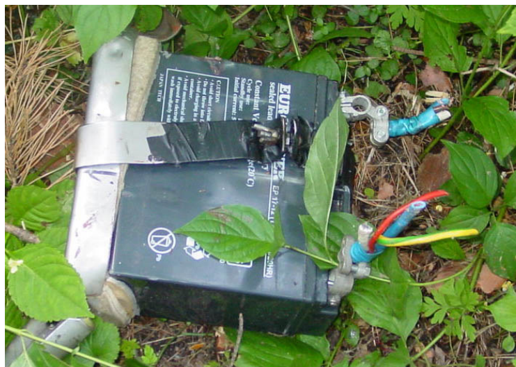
Fot.16 – Akumulator wyrwany ze swego zamocowania.
