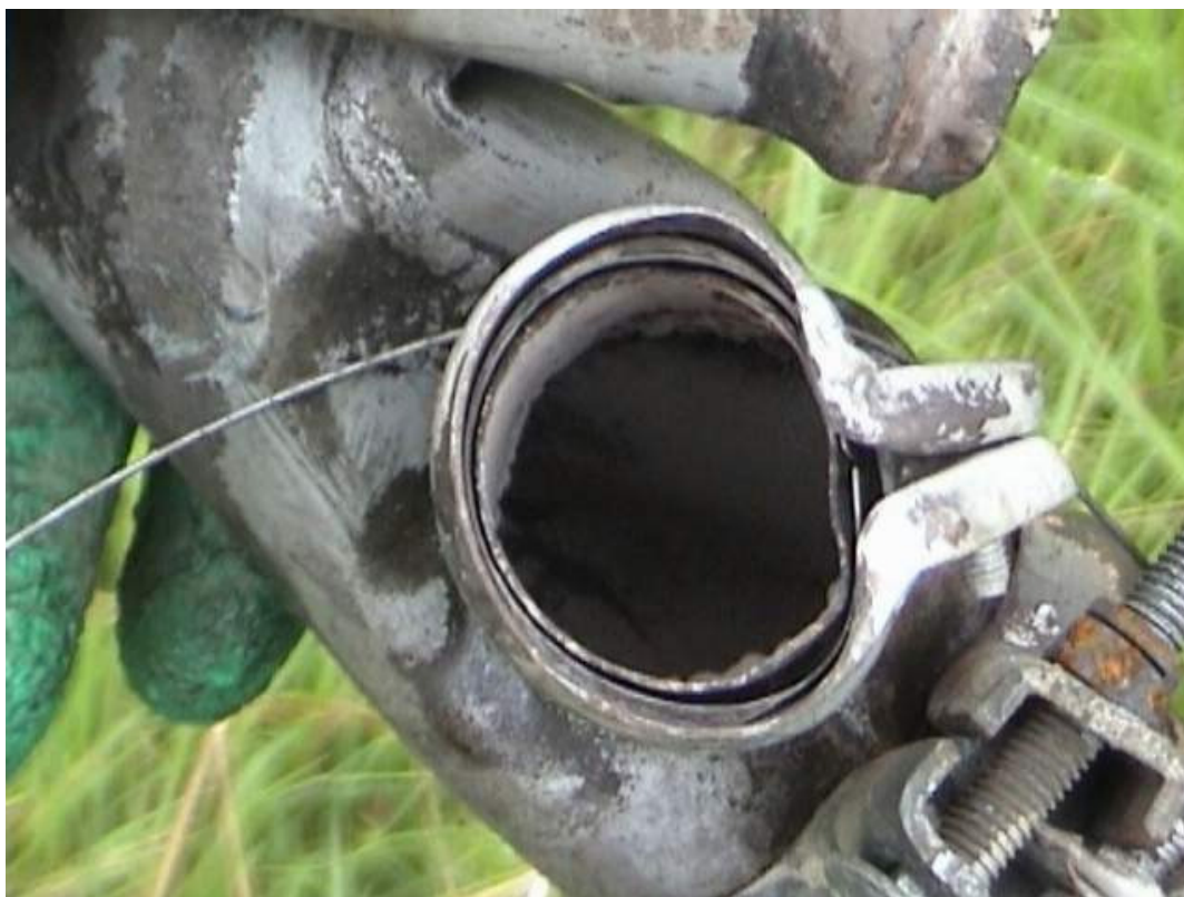
Fot.25 – Zbliżenie jednego z kanałów kolektora – widoczny brak śladów oleju.
