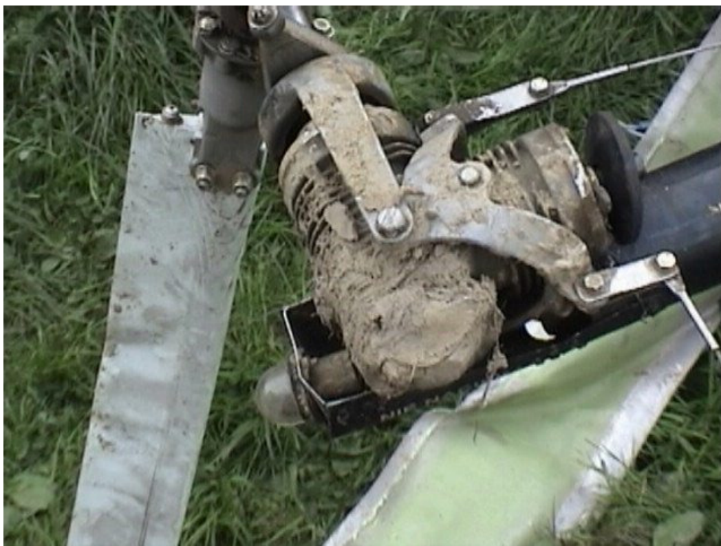
Fot.10 – Uszkodzona piasta wirnika ogonowego, widoczna zniszczona łopata wirnika ogonowego.
