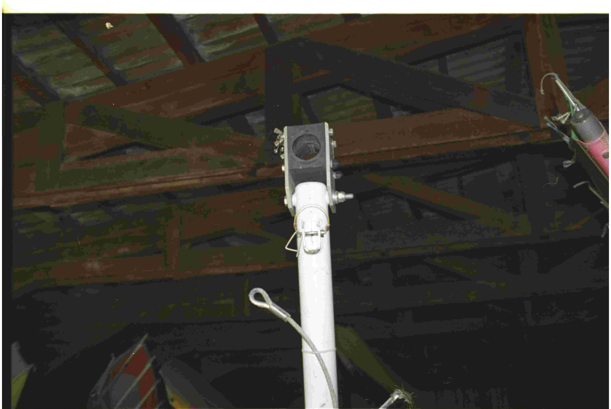
Fot.7 – Zakończenie masztu wózka z okuciem mocowania skrzydła (brak widocznych uszkodzeń).
