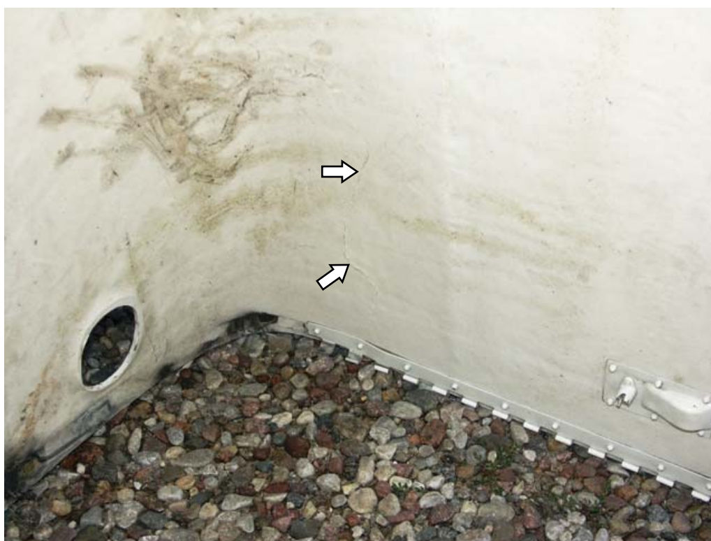
Fot. 10 – Ślady pęknięć widoczne od środka osłony - prawa strona.
