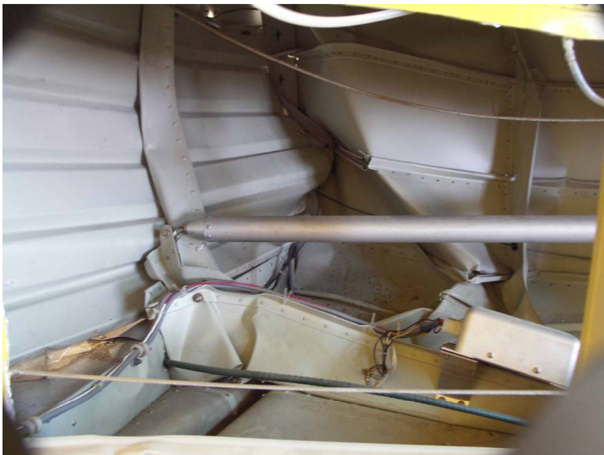
Fot.45 – Sterowanie w kadłubie od strony ścianki bagażnika.
