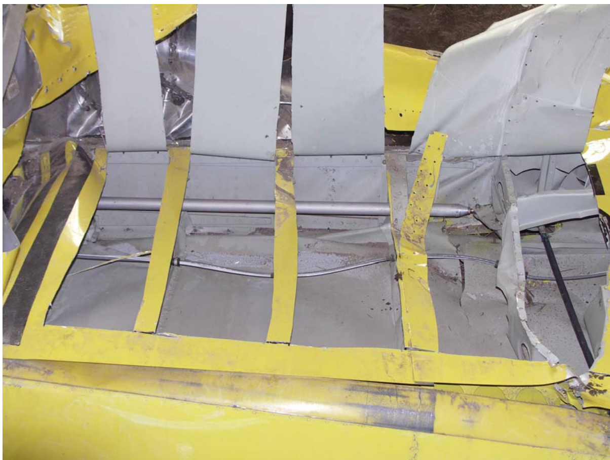
Fot.49 - System sterowania lotką w prawym skrzydle po odsłonięciu pokryć.
