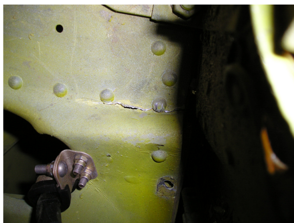
Fot.5 – Deformacja i pęknięcie podłogi.
