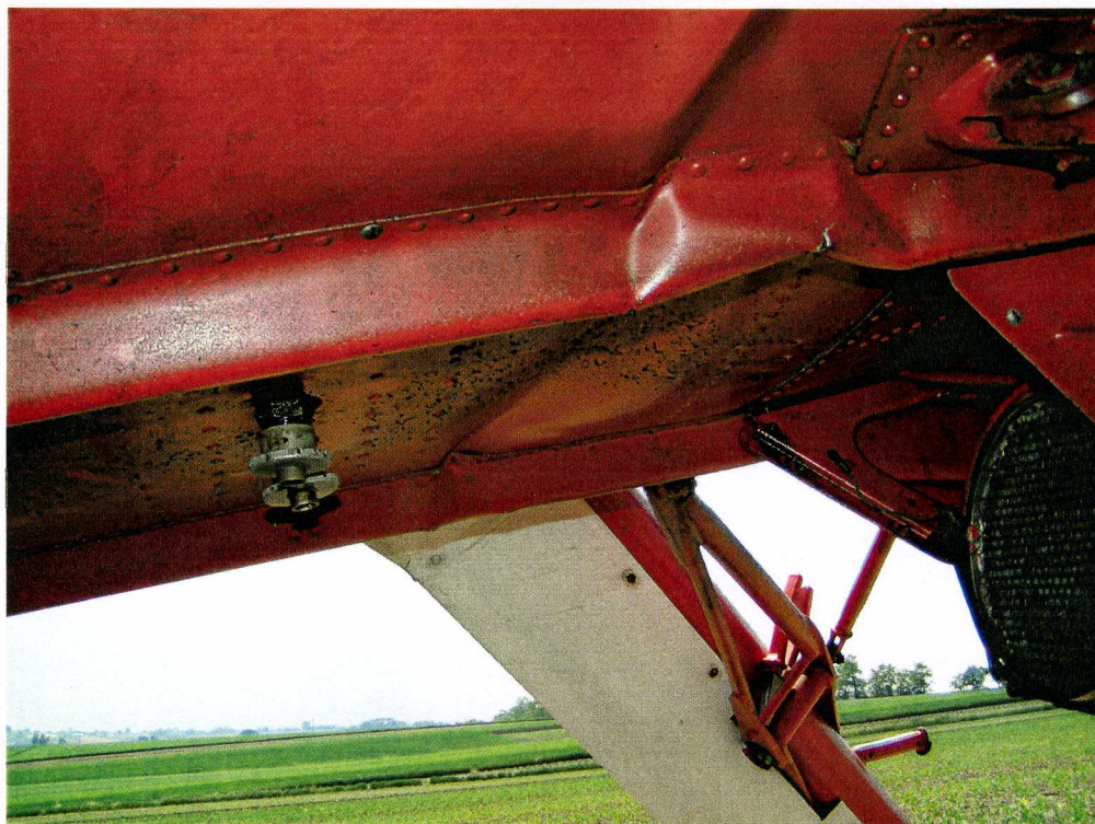
Fot. 7 – uszkodzenie blach dolnego pokrycia kadłuba za węzłem mocowania goleni podwozia głównego – strona prawa
