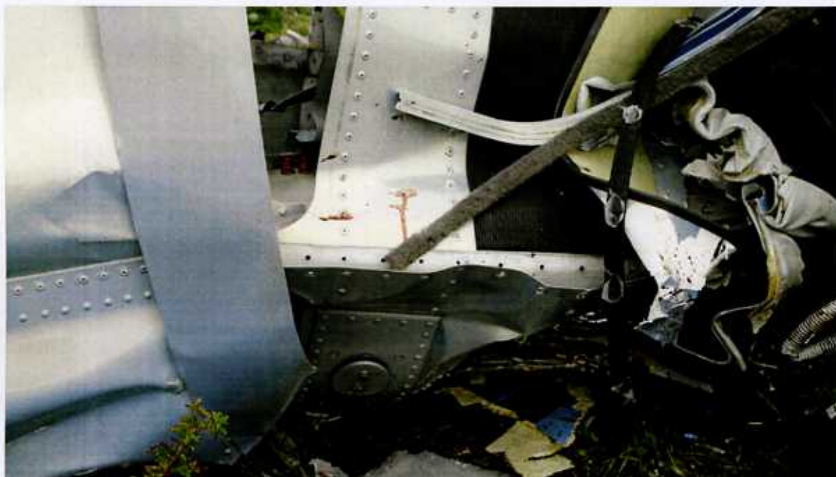
21 – Prawa końcówka centroplata. Widoczne nitowanie wzmocnienia żebra siłowego mocowania goleni podwozia oraz wyprowadzenie goleni, osłonięte okrągłą pokrywką.
