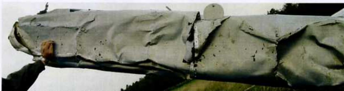
23 – Prawe skrzydło w widoku od przodu. Widoczne zniszczenia pokryć noska i integralnego zbiornika paliwowego.
