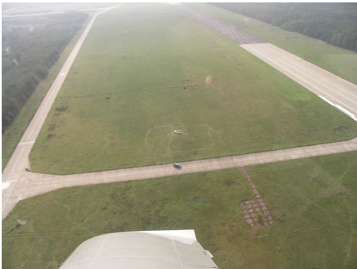
Fot. 3 Położenie miejsca zderzenia samolotu z ziemią względem drogi startowej i dróg kołowania.
