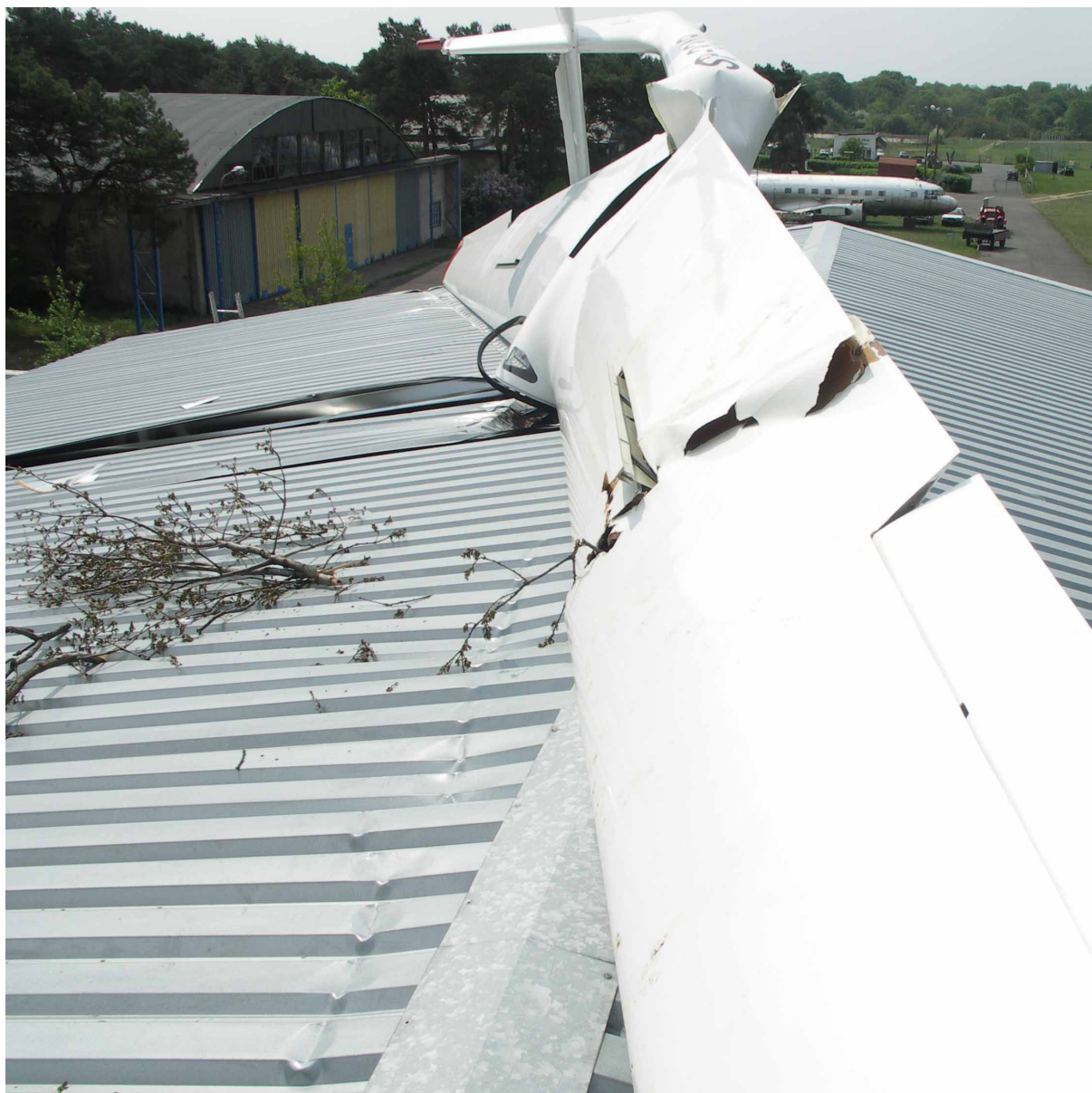
10 – Szybowiec wbity w dach hangaru, lewa strona. Widoczne uszkodzenia lewego skrzydła i wgniecenie dachu.
