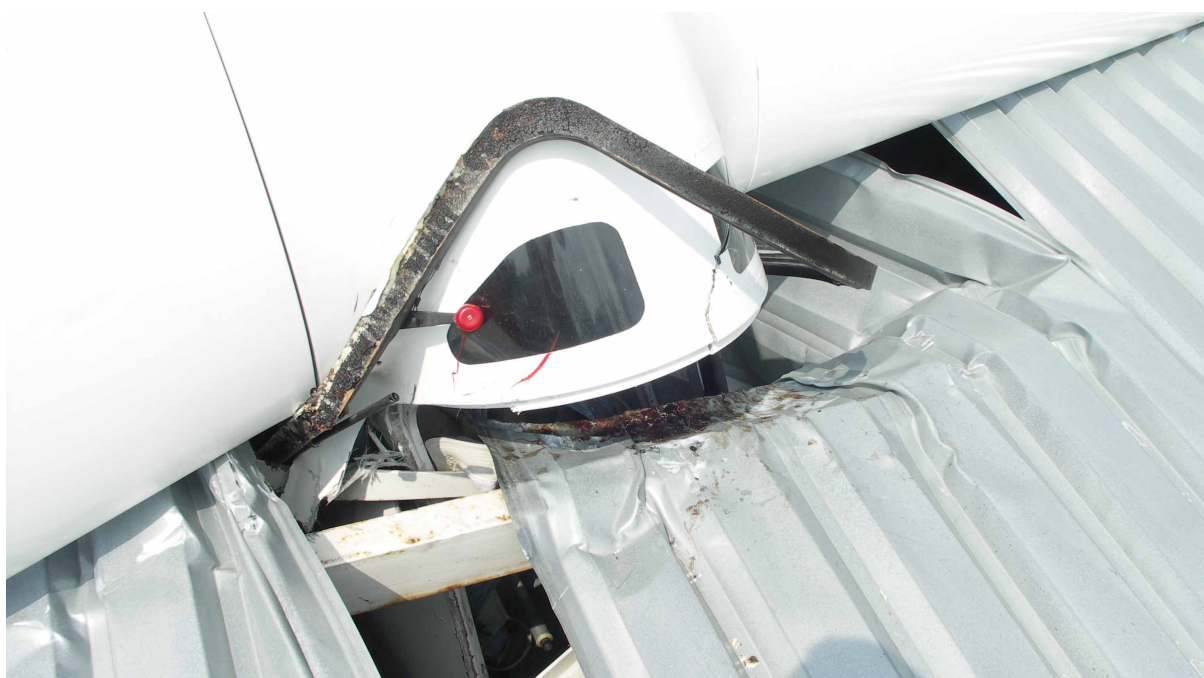
7 – Miejsce wbicia się kadłuba szybowca w dach hangaru.
