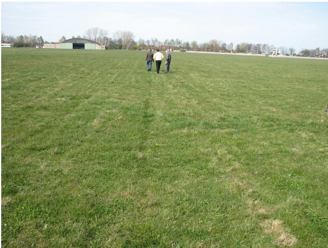
Fot. 4 Nawierzchnia lotniska w miejscu pierwszego przyziemienia samolotu
