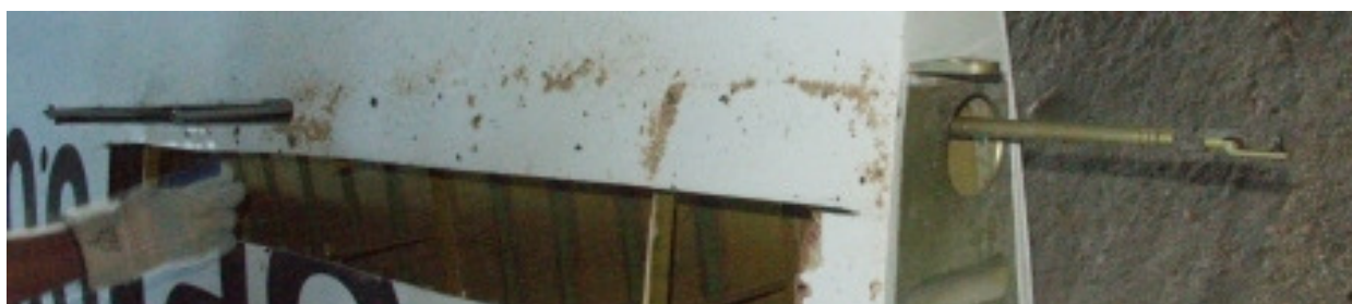
81 – Keson lewego skrzydła otwarty dla stwierdzenia ciągłości układów sterowania [fot.PKBWL].
