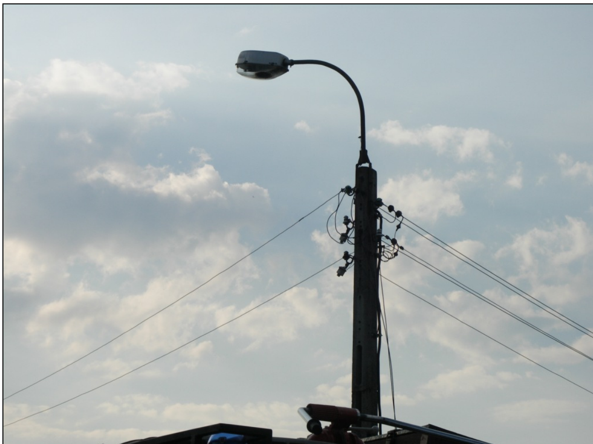
8 – Widok na słup sieci energetycznej i zerwane przez samolot przewody po lewej stronie podejścia do awaryjnego lądowania.
