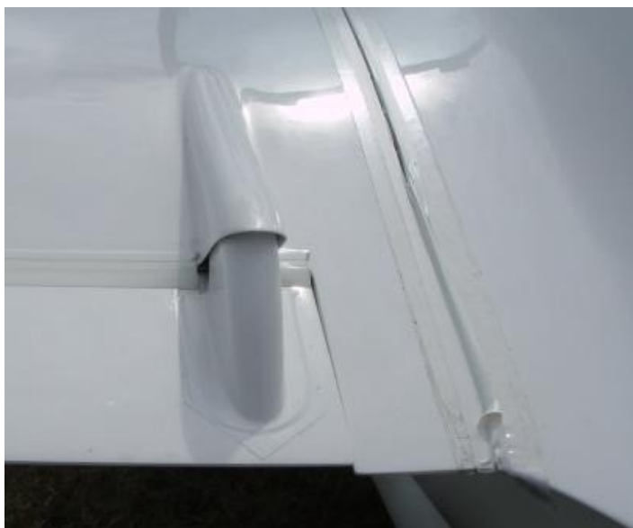
14 – Krawędź spływu lewego skrzydła przy kadłubie.
