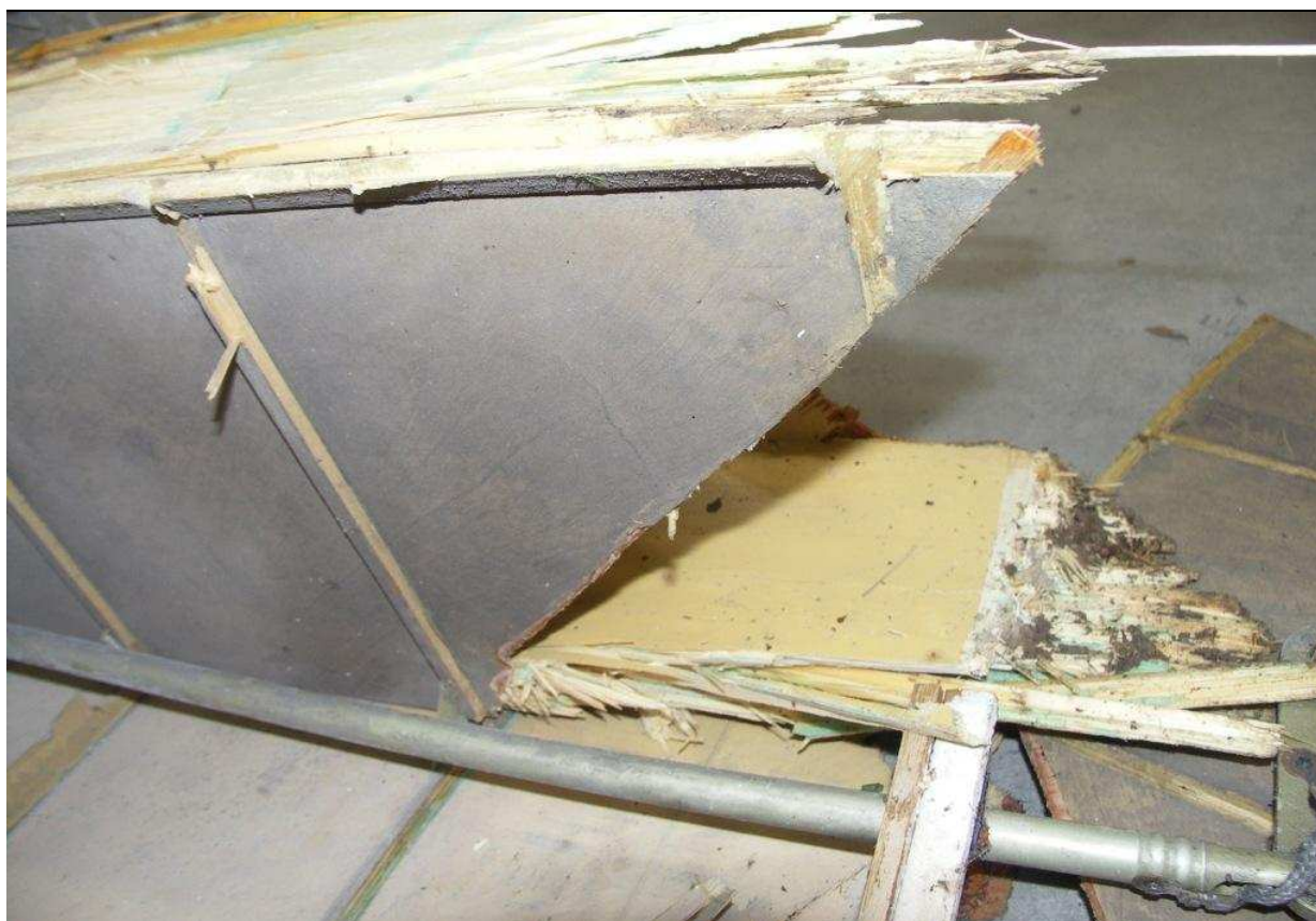
44 – dalsza część strefy nasadowej prawego skrzydła. Widać zniszczony dolny pas dźwigara, dolne pokrycie kesonu i ściankę dźwigara, wzdłuż której biegnie popychacz układu sterowania.
