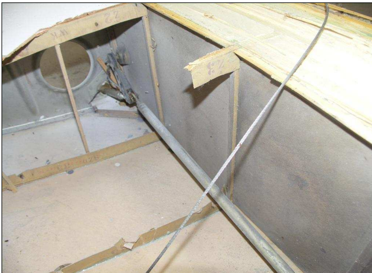
43 – Strefa nasadowa prawego skrzydła. Widać metalowe żebro nasadowe, dolne pokrycie kesonu i ściankę dźwigara, wzdłuż której biegnie popychacz układu sterowania.
