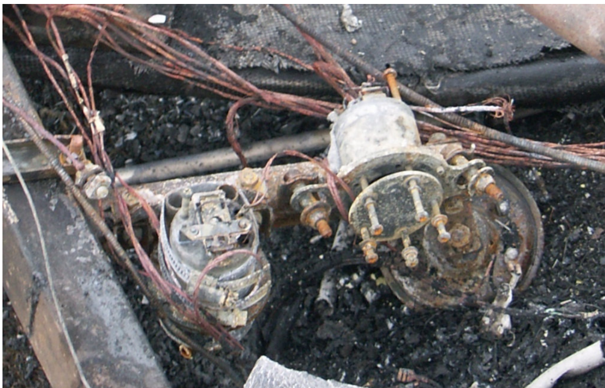
27 – Szczątki osprzętu elektrycznego zespołu napędowego, pozostałe przy głównej belce wózka.
