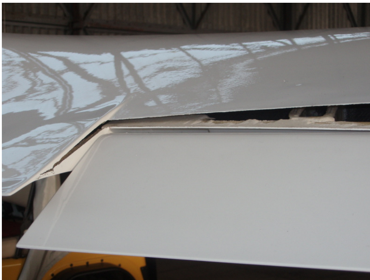
4 – Strefa rozklejenia konstrukcji.
