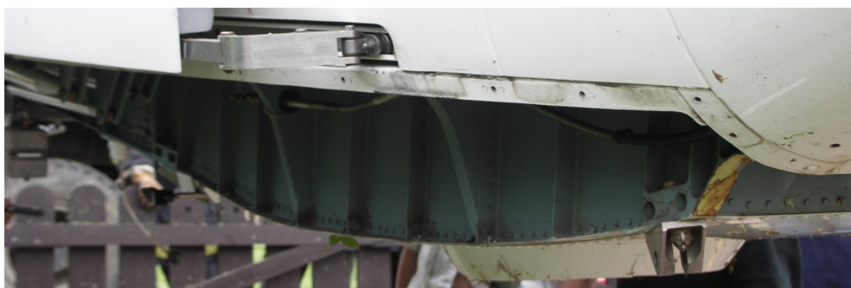
27 – Lewy dźwigar wzdłużny kadłuba – bez widocznych uszkodzeń.
