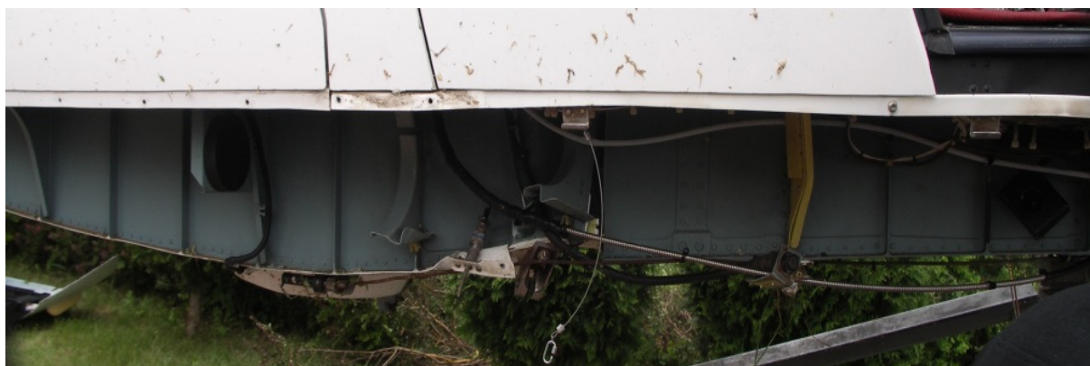
23 – Przelamanie prawego dźwigara wzdłużnego kadłuba w części środkowej.
