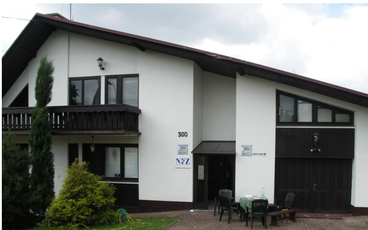
9 – Dom przy ul. Słonecznej 37, widać uszkodzenie dachu nad wejściem.
