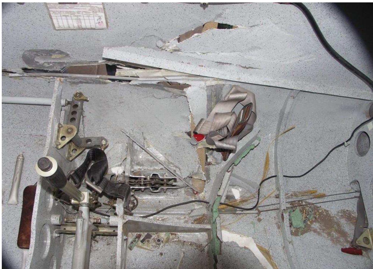
44 – Wnętrze kadłuba po usunięciu siedziska instruktora – widok z prawej strony. Widoczne pęknięcia pokrycia i rozklejenia. Dobrze widoczna dźwignia pośrednia sterowania łotkami z odłamaną końcówką popychacza.
