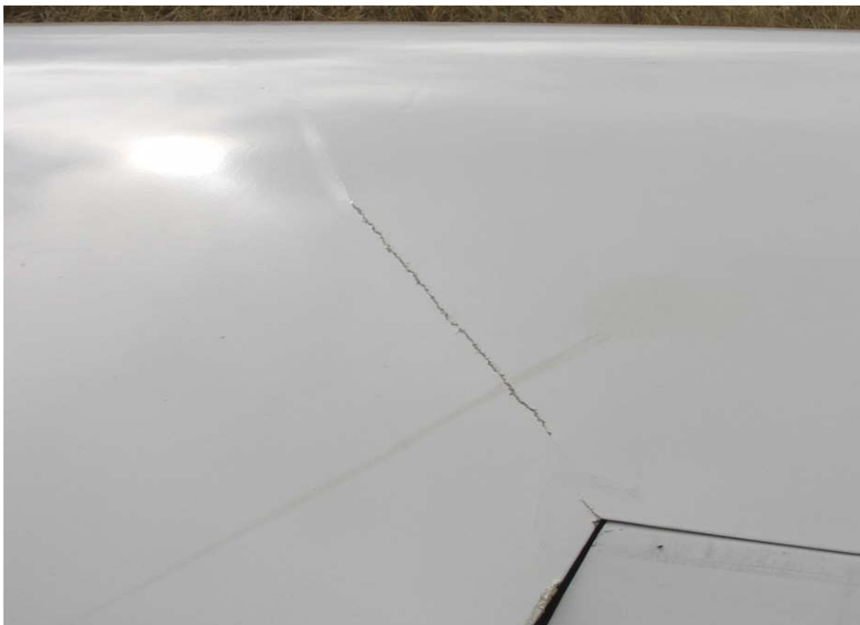
38 – Pęknięcie górnego pokrycia skrzydła, biegnące od wewnętrznego naroża wykroju lotki - zbliżenie.
