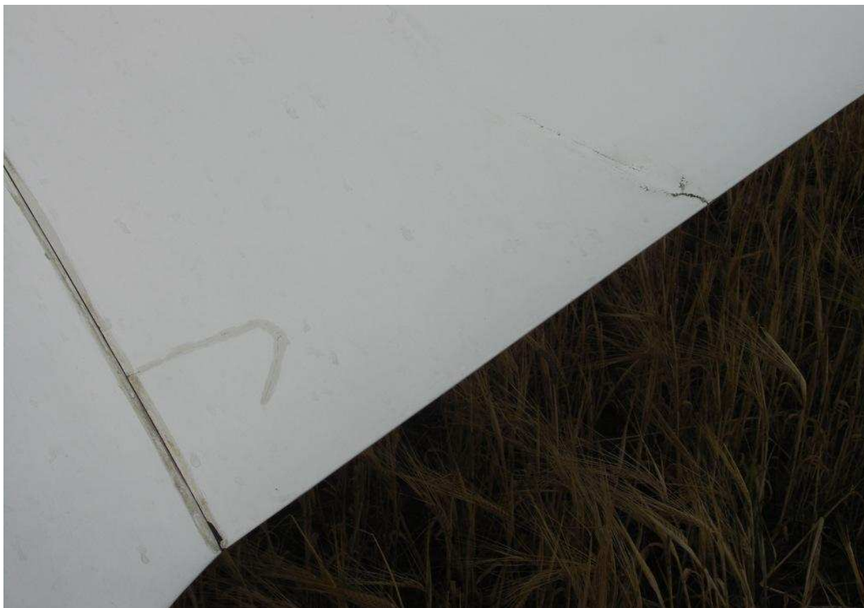
35 – Uszkodzenie u nasady prawego skrzydła – pęknięcie pokrycia przy krawędzi spływu.
