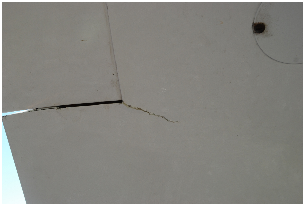
Fot. 3 Pęknięte dolne pokrycie u nasady lotki.
