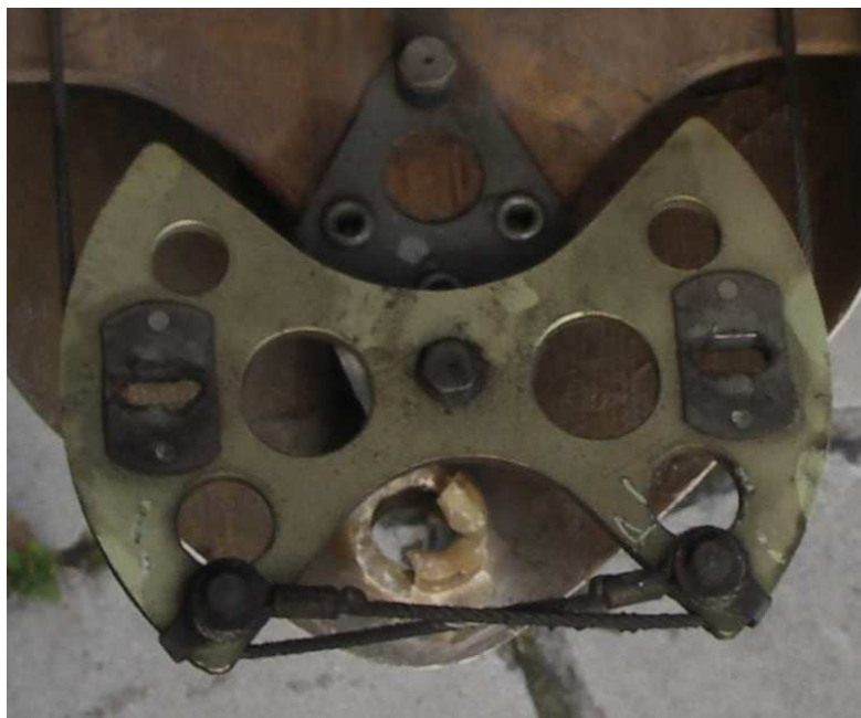
10 - Uszkodzenia dolnego węzła zawieszenia steru kierunku na stateczniku - zbliżenie.
