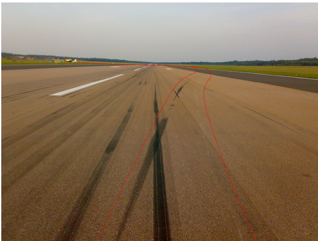
2. – Ślad lądowania samolotu na pasie startowym. Widoczne rysy na nawierzchni lotniska utworzone przez goleń podwozia tylnego. Kolorem czerwonym zaznaczona została trasa wykonana przez samolot.
