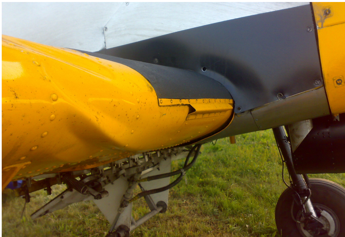
Fot. 1 Pofalowane pokrycie centroplata oraz wyboczone pokrycie kadłuba
