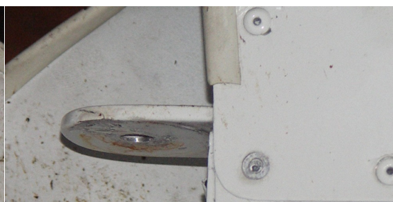
27 – Okucie dźwigara głównego lewego skrzydła – brak widocznych odkształceń i uszkodzeń.
