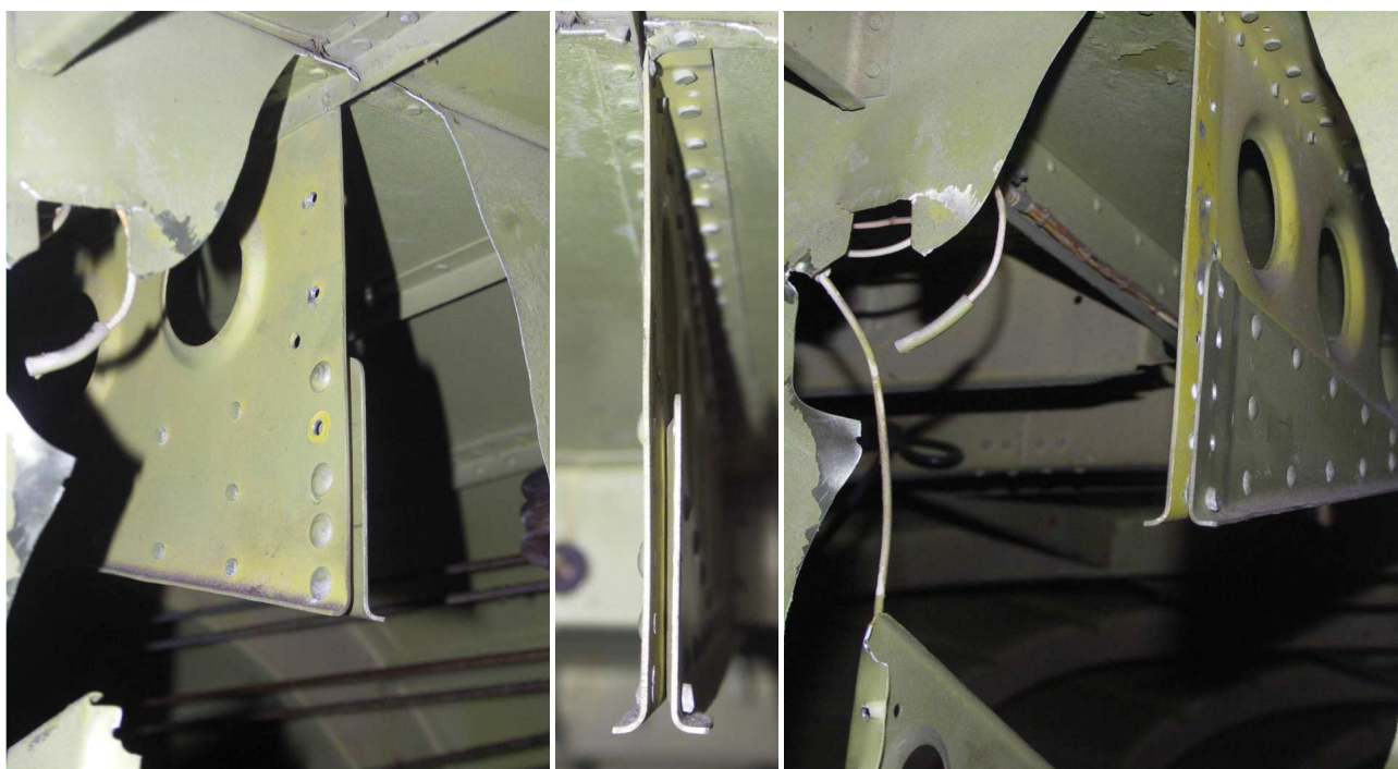
2, 3, 4 – Zbliżenia na elementy struktury kadłuba w rejonie uszkodzenia – widoczne elementy wzmacniające zamocowanie linek pozostałe w kadłubie.
