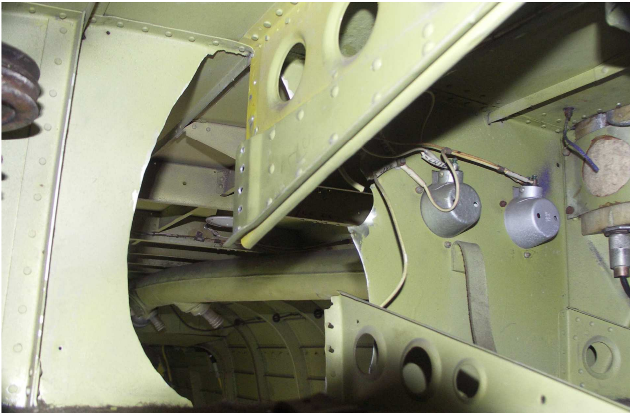
5 – Ogólny widok uszkodzonej wręgi od strony tylnej części kadłuba – widoczne wyrwanie znacznego fragmentu ścianki wręgi wraz z lampką sygnalizacyjną czerwoną oraz elementy wzmacniające zamocowanie linek pozostałe w kadłubie.
