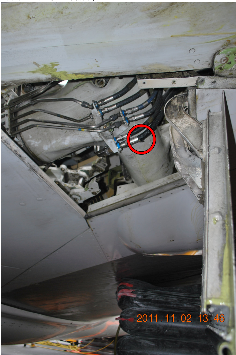
Fot. 7 Widok na przewody hydrauliczne prawego podwozia głównego samolotu SP-LPC.
