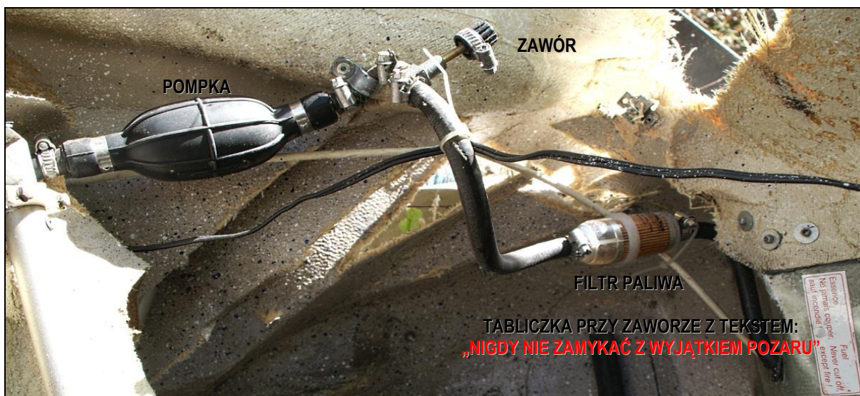
42 – Elementy instalacji paliwowej na lewej burcie kabiny [foto: KPP Radomsko].
