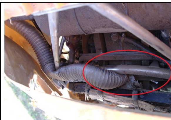
Rys. 4. Uszkodzenia łoża silnika
