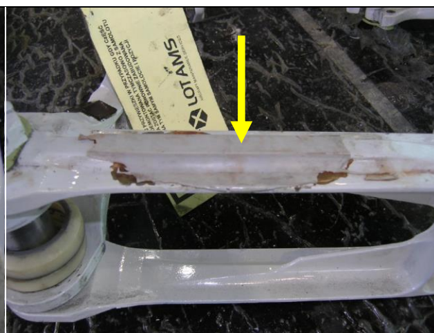
Miejsce naniesienia uszczelniacza i farby.
