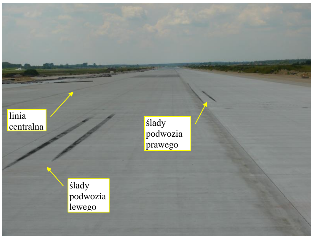
Fot. 7. Ślady przyziemienia samolotu Bombardier CRJ-700 (~870[m] od początku nawierzchni RWY 27).
