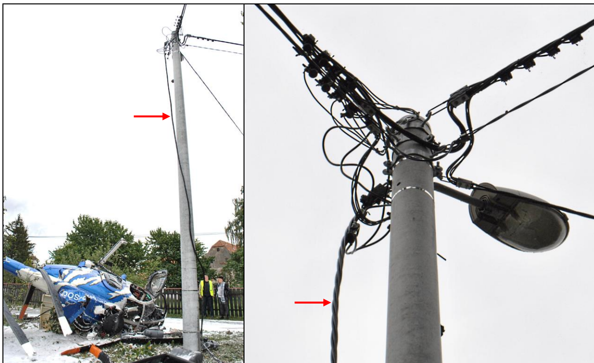
9, 10 – Miejsce wypadku od strony zachodniej – dobrze widoczny żelbetowy słup linii energetycznej i jego szczyt oraz zerwany przewód [foto: Policja].
