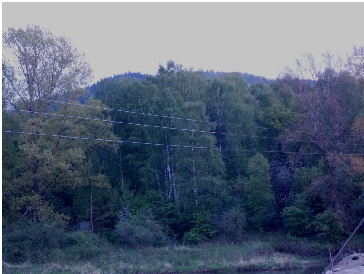
Rys. 3. Widok zerwanej i następnie naprawionej trójprzewodowej linii energetycznej SN.
