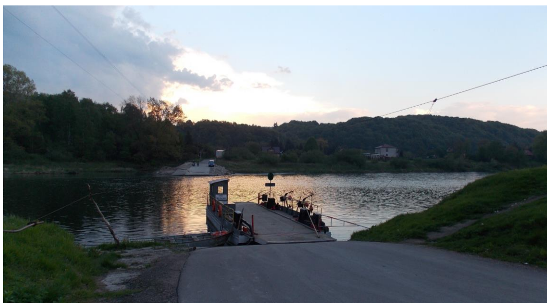
Rys. 2. Widok przeprawy promowej od strony Czchowa. Po lewej stronie widoczna linia energetyczna SN, a po prawej lina asekuracyjna promu.
