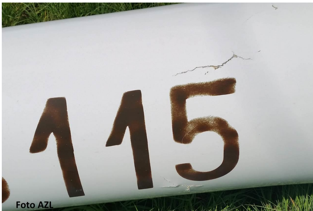
Ilustracja nr 3. Uszkodzenia belki ogonowej szybowca na wysokości znaków rozpoznawczych
