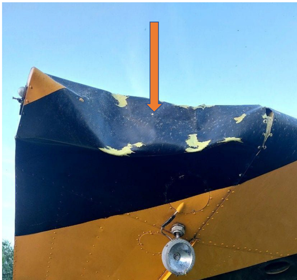
Rys. 2. Uszkodzenie pokrycia końcówki prawego skrzydła
