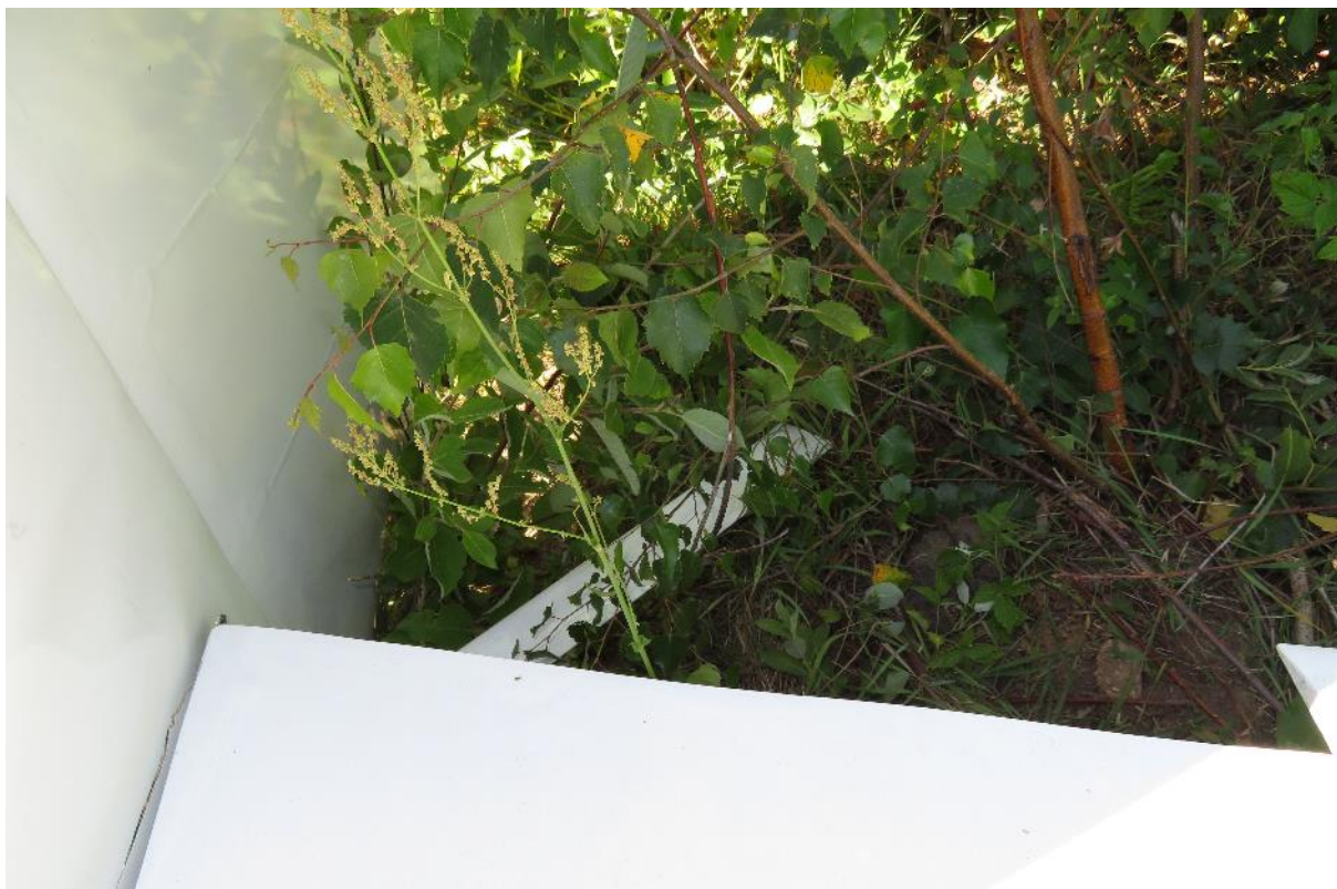
Rys. 8. Wyrwana z trakcie procesu niszczenia klapka odciążająca
