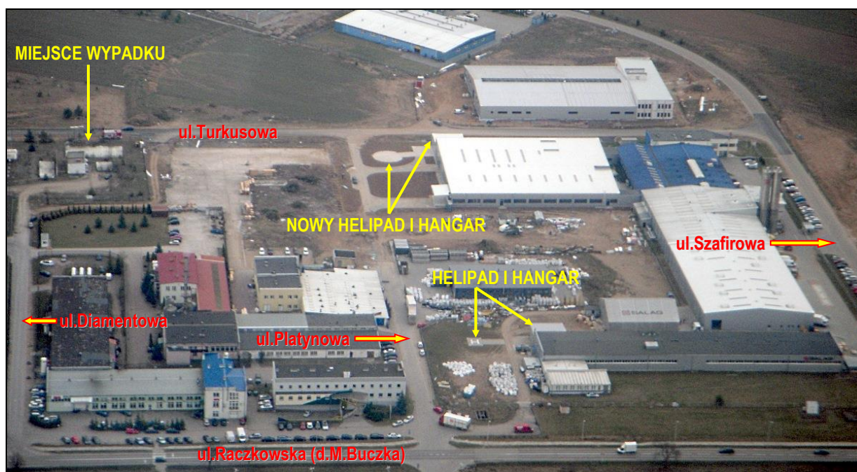
4 – Teren i okolica firmy Salag na zdjęciu lotniczym od strony północno-zachodniej [fot.I.Przybyła, Suwalska Szkoła Lotnicza].
