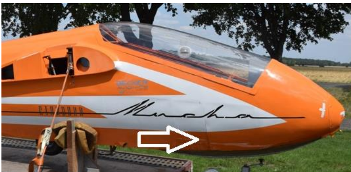
Rys. 3 Pęknięcie sklejki pokrycia z prawej strony kadłuba [źródło: użytkownik]
