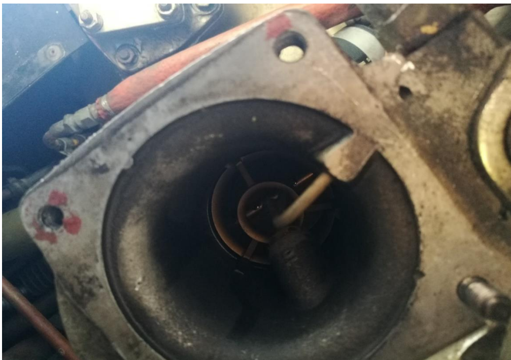
Rys.8 Ślady pożaru (nagar) w gardzieli gaźnika. [Źródło, PKBWL ].
