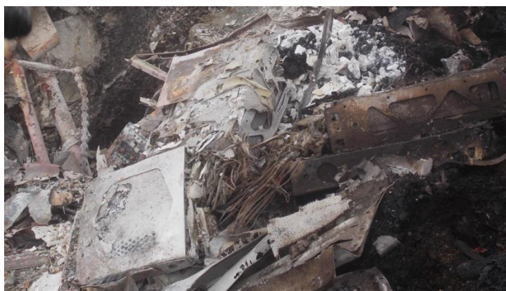
Rys.7. Zniszczone pożarem urządzenia radionawigacyjne
