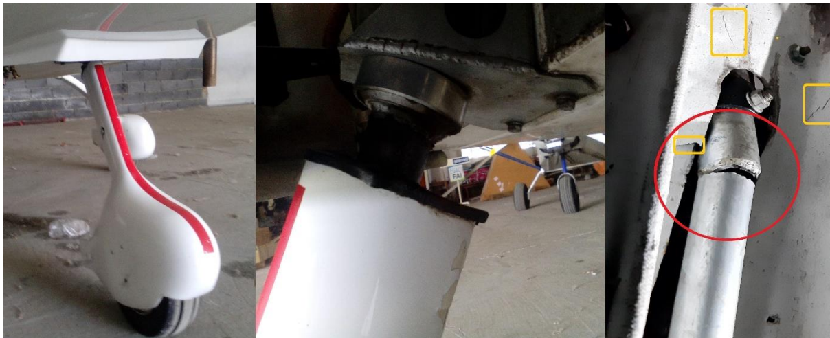
Rys. 2. Uszkodzona goleń przedniego podwozia (kolor czerwony), widoczne pęknięcia laminatu (kolor pomarańczowy) [źródło: PKBWL]
