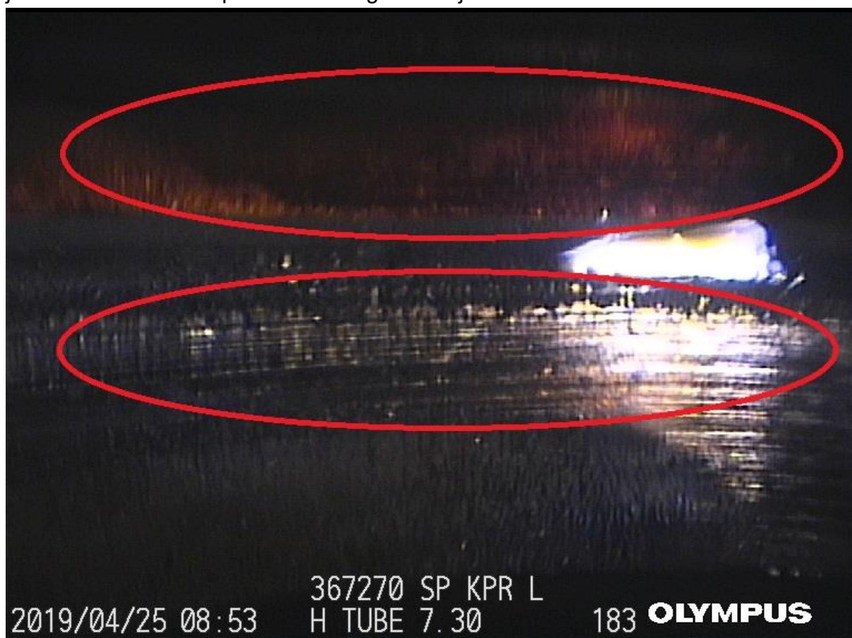
Rys.2 Widok pozostałości starych uszczelnień gumowych na ściankach portów[źródło, użytkownik].
