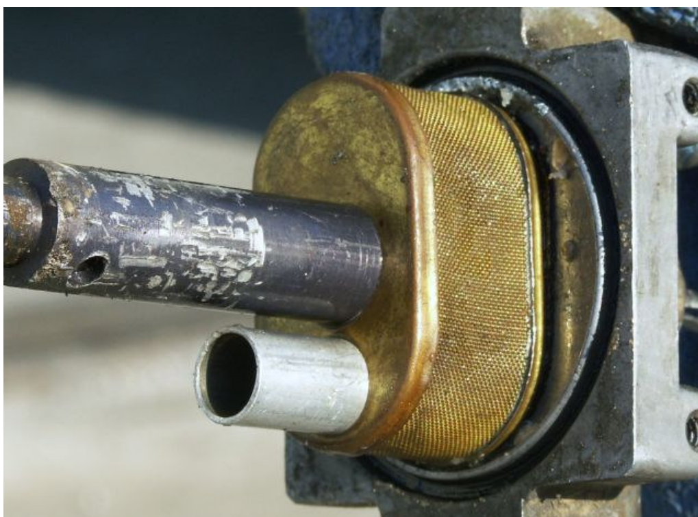
71, 72. Widok na element filtrujący filtra paliwa zabudowanego na przegrodzie ogniowej. Element filtrujący jest czysty, brak zanieczyszczeń i osadów. Filtr ten nie mógł być przyczyną blokady dopływu paliwa do silnika.
